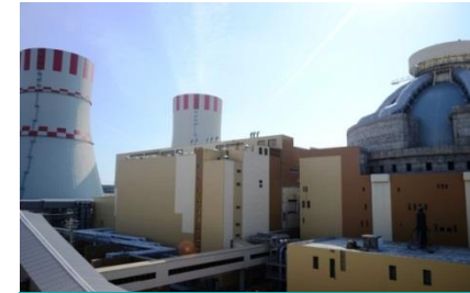
Russia, Novovoronezh NPP II, Unit 1 - 1200 MW
